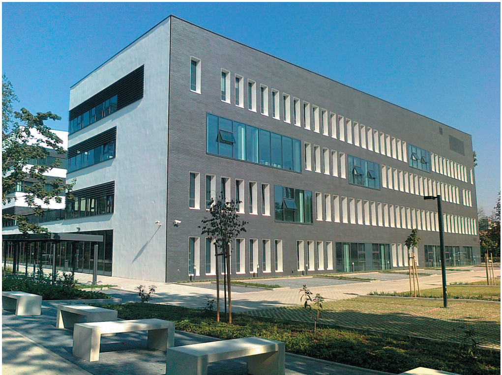
Geocentrum I – siedziba wydziału od 2013
